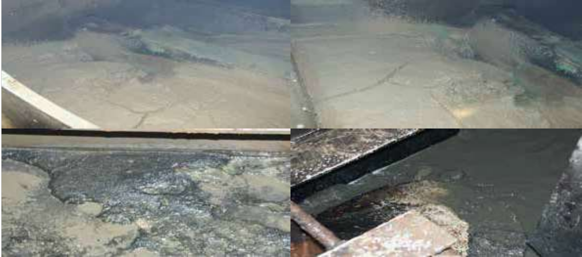
Mucking Pump 를 이용한 세정 시작
