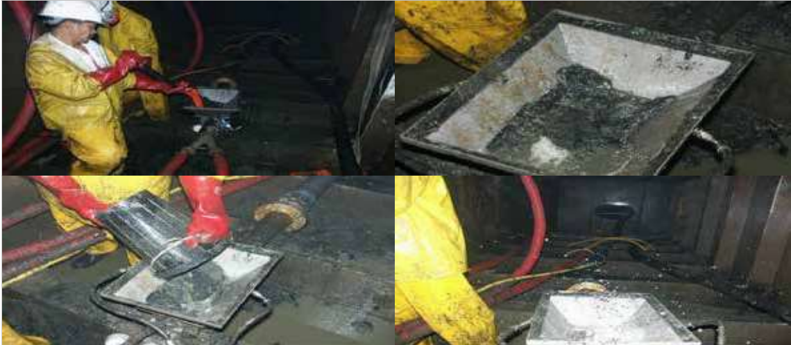
Vacuum Pump 를 이용한 세정 시작
